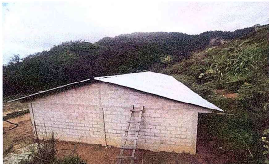
Foto1: Techo nuevo del edificio
