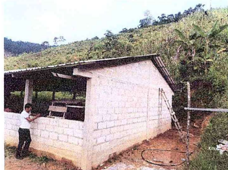
Foto 2: muro perimetral de la escuela
