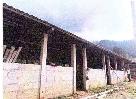
Foto 4: instalacion de balcones
