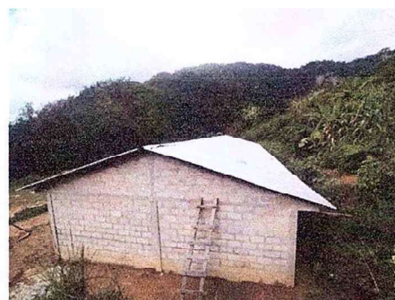
Foto 6: Finalizacion de la obra
